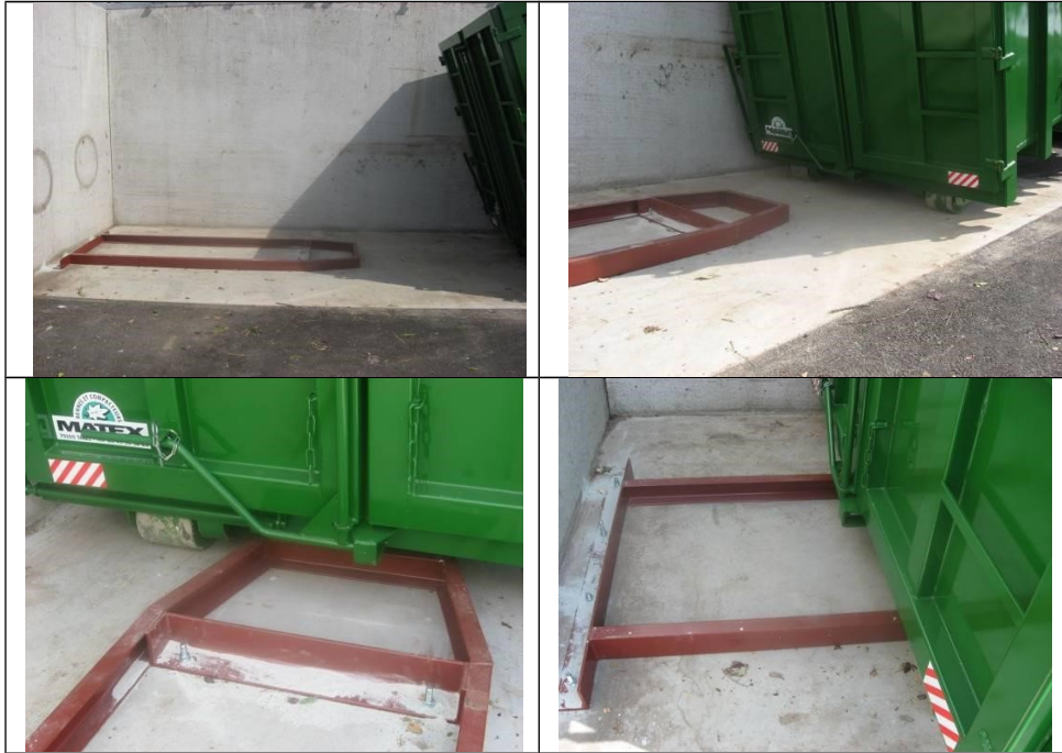
Figure 10 : Photographies des rails de guidage de déchèterie
