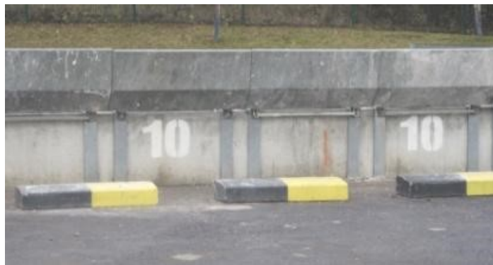
Figure 7 : Photographie des butées de roues mises en place sur la déchèterie de Sarcelles
